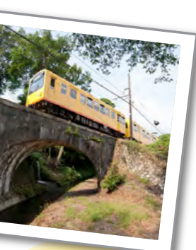
◀全国に存在する「めがね橋」の中でも珍しいコンクリートブロック製
