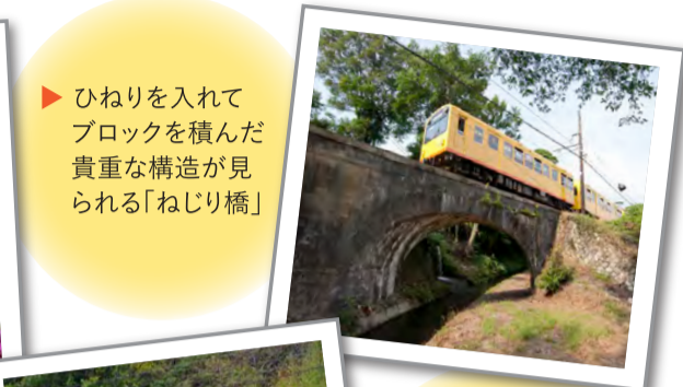
◀全国に存在する「めがね橋」の中でも珍しいコンクリートブロック製
